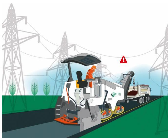
De même, il est indispensable de repérer en amont les réseaux aériens et de garder la distance de sécurité minimale avec les réseaux haute-tensions.
